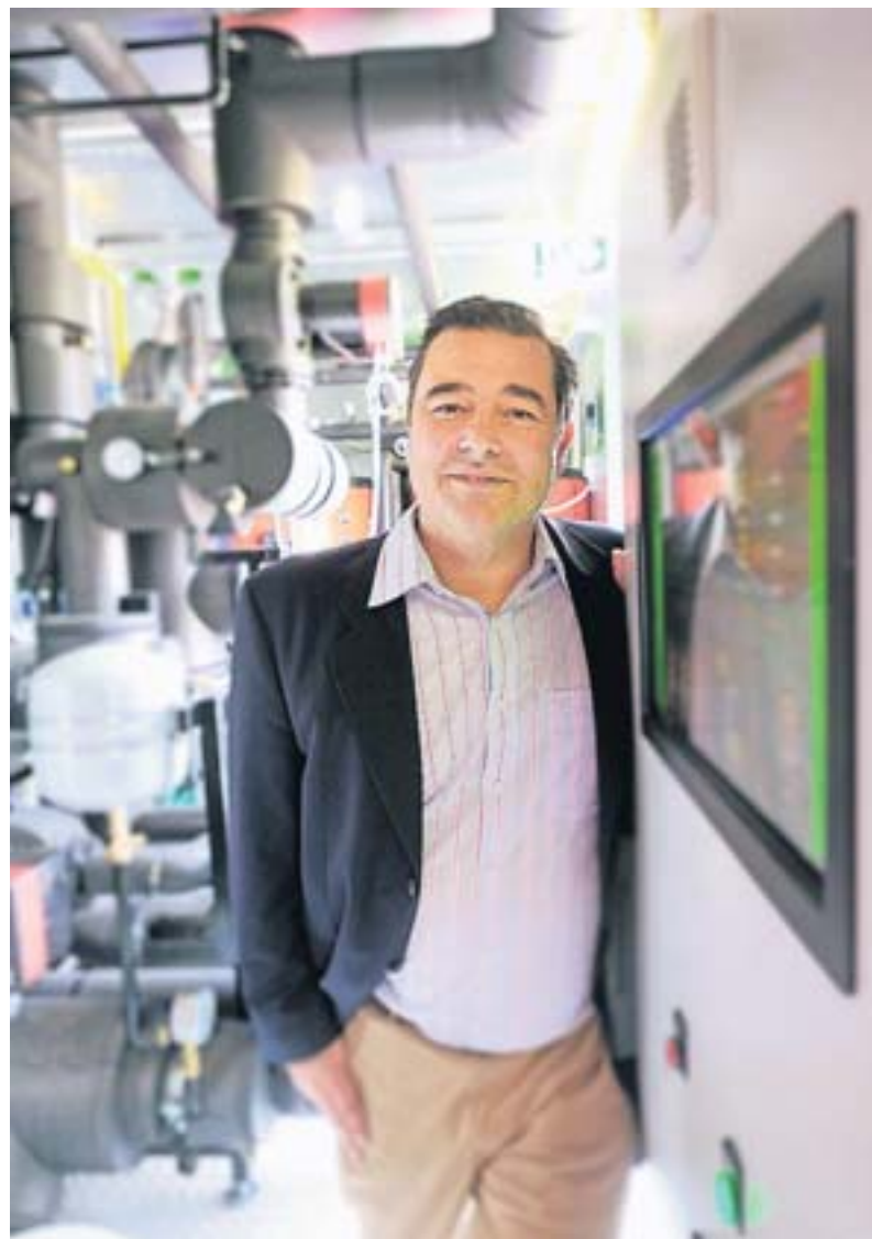
Unternehmer Michael Kleinbongartz vor seinem Blockheizkraftwerk. Im Vordergrund die Bedientafel, im Hintergrund die Anlage.
